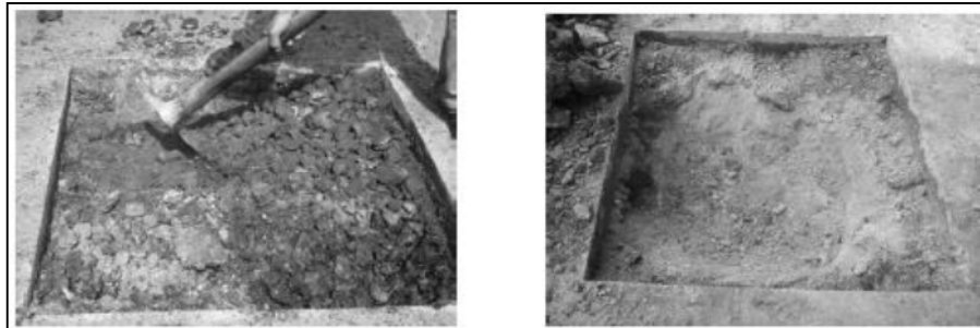
Figura 9: Material de Base y Sub-rasante en Estaciones 1+000 hasta 2+500
