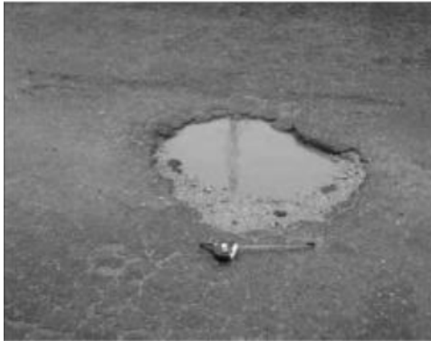
Figura 7: Daño Tipo Huecos
